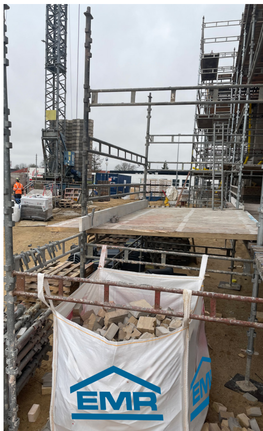
Under opmuring fra platform opbygges der et stillads til fastholdelse af bigbags, hvori afskær sorteres.
